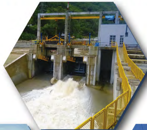
OBRAS CIVILES CENTRALES HIDROELÉCTRICAS
